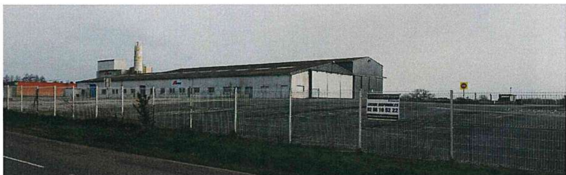
1 - Vue sur la friche Rector (parcelles cadastrales YH149, YH31, YH89, YH90 et YH239) depuis la route de Pont Gwin (VC9) Photographie FUTUR PROCHE – 23/01/2020
