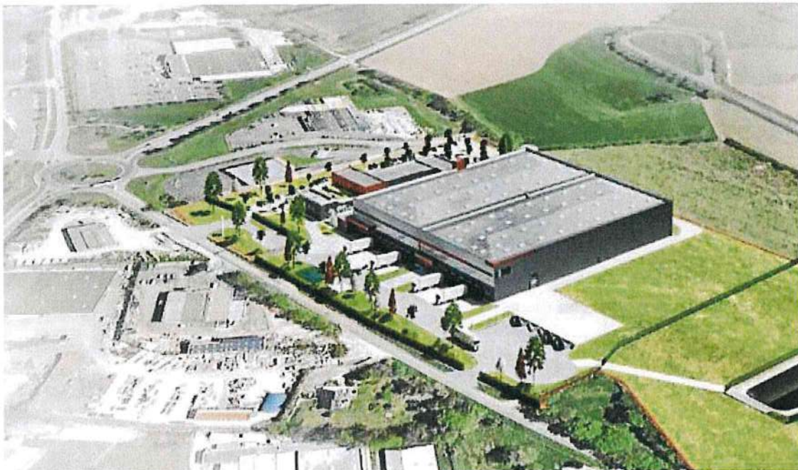
Vue depuis le Sud-Ouest (ZI des Pays-Bas) – Source : SODISE ©Facet Ingénierie)
